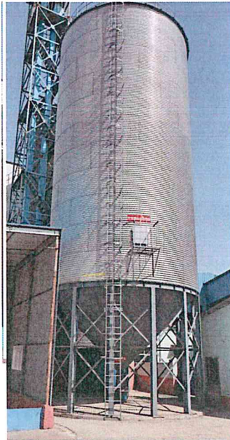
农业科技有限公司 封闭式仓储设施
